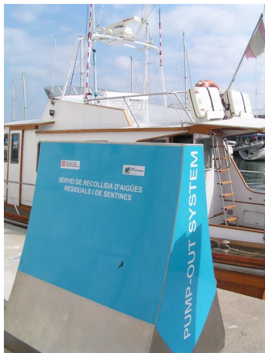
Equipo de succión de las aguas residuales y las sentinas de las embarcaciones
