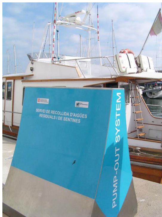
Equip de succió de les aigües residuals i les sentines de les embarcacions
